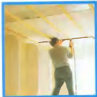
9. Обшивку потолка крепим к рейкам-маякам, которые устанавливаем вдоль длинной стороны помещения.
