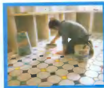
10. Делаем пол: восьмиугольные плитки и резноцетвные вставки укладываем на тонкий слой раствора. После схватывания раствора заделываем швы.
